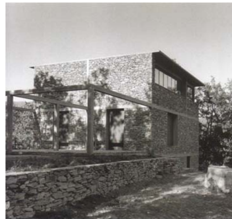
Casa de Piedra, Herzog & deMeuron
