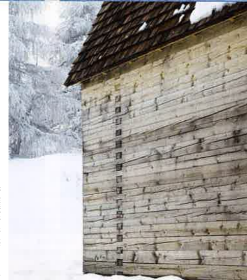
Das Gebäude wurde mit doppelter Nut-Feder Verkämung als traditioneller Strickbau ausgeführt
