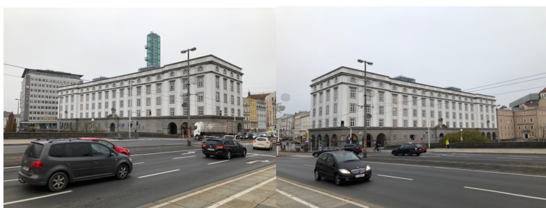
Foto 4 und 5: Ansicht Brückenkopfgebäude donauseitig
