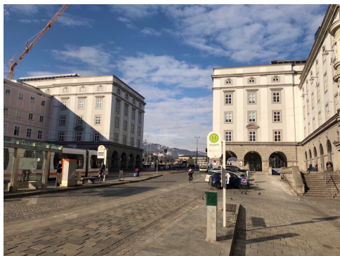
Foto 3: Brückenkopf Ost und West
